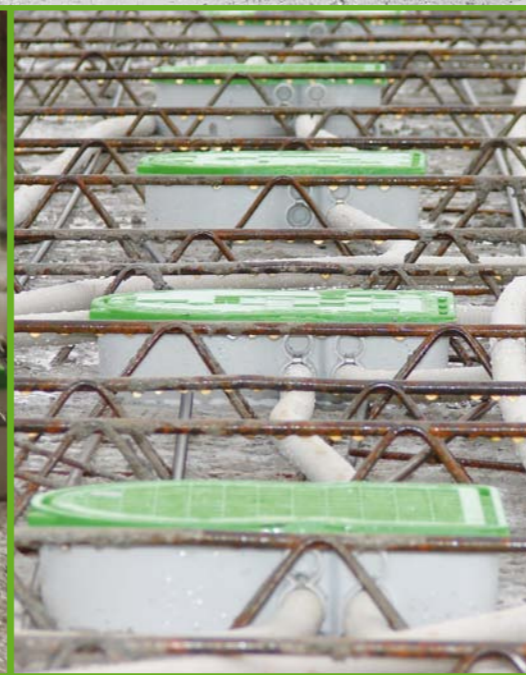
Behuizingen aansluiten op de bouwplaats
