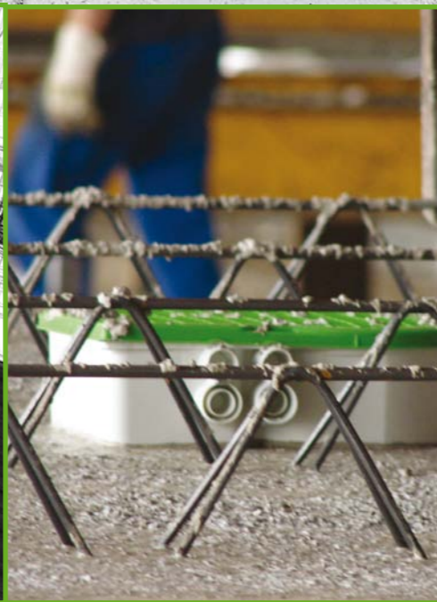
Behuizingen instorten in de betonfabriek
